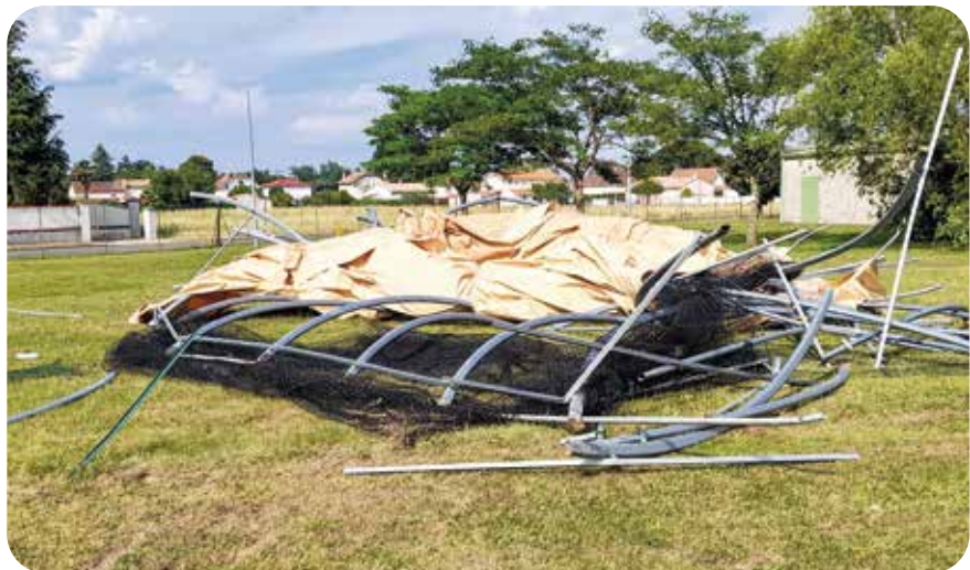
Tunnel de frappe après la tempête
